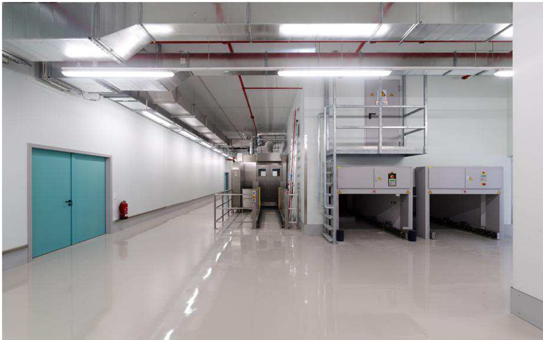
Quelle: Staatliches Hochbauamt Ulm
